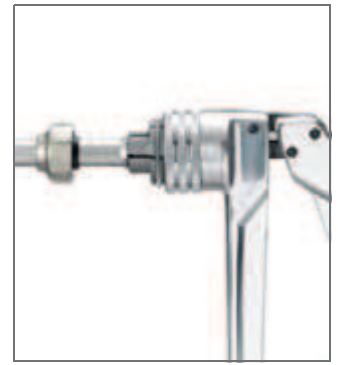
Rys. 14-6 Kielichowanie rury przyłączeniowej
