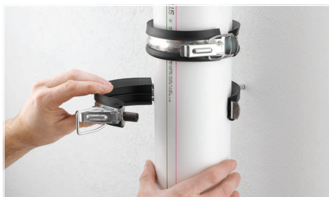
Rys. 6-2 Zamknięcie obejmy podtrzymującej
