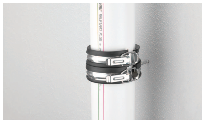
Rys. 6-3 Zainstalowany uchwyt tłumiący
