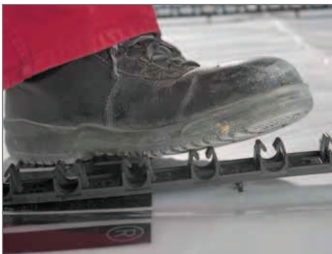
Rys. 3-34 Wcisnięcie listwy RAUFIX w konstrukcję podłogi
