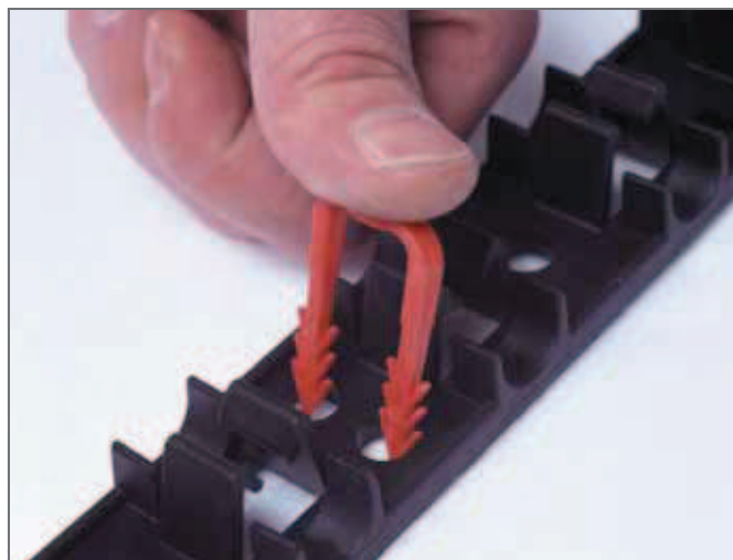
Rys. 3-35 Wcisnięcie szpilki mocującej w konstrukcję podłogi
